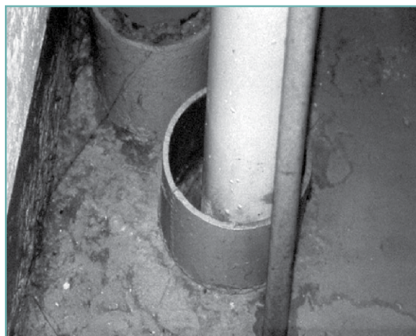
Figure 4-30 Pénétration type dans un plancher
