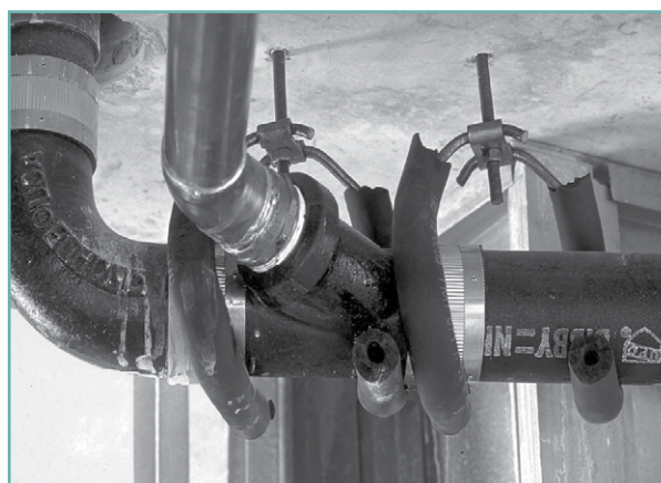
Figure 4-14 Points de pénétration de plomberie
