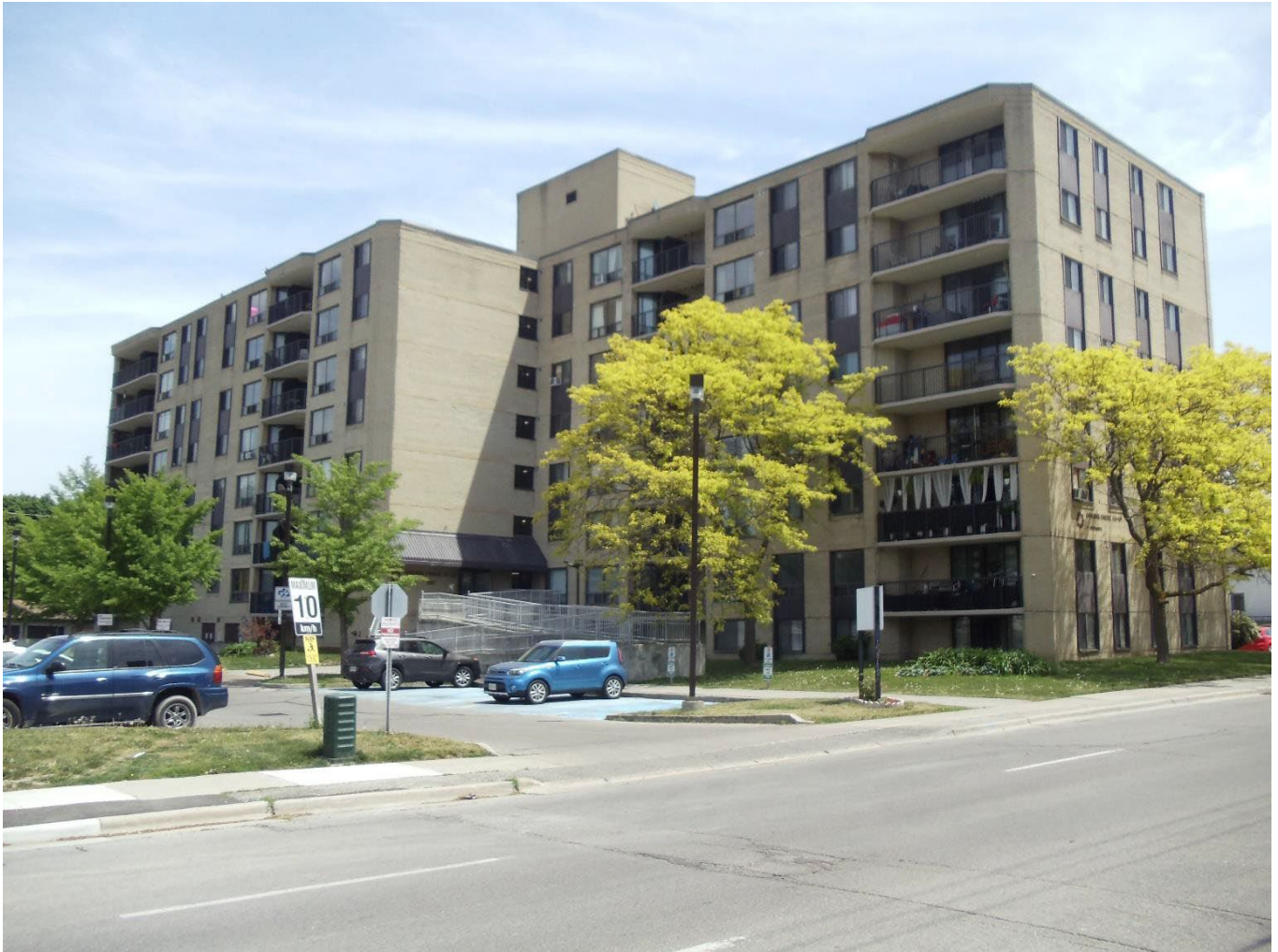
Figure 1 : Coopérative d'habitation d'Oshawa Creek, 233, rue Albert, Oshawa
